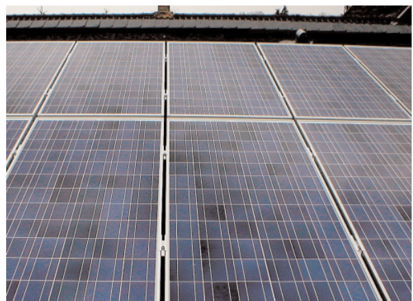
Bild 5: Ansicht Modulfeld (sichtbare vertikale Modulabstände)
