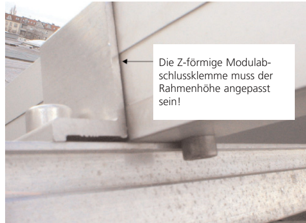
Bild 2: Abrutschsicherung mit Z-förmiger Modulabschlussklemme an der Außenkante
